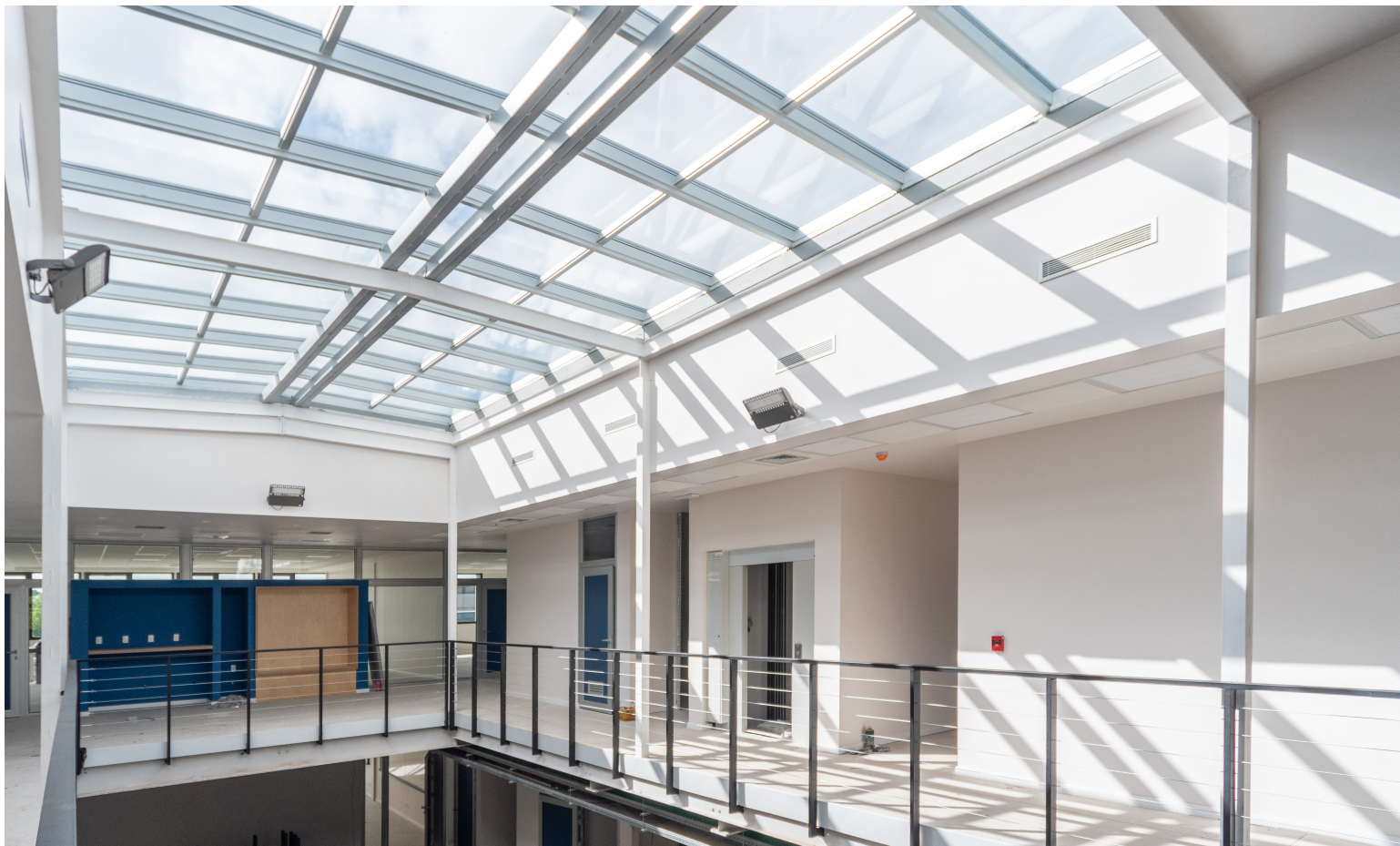
El edificio se proyectó con una estructura mixta, siendo la estructura principal metálica de alma llena, entrepisos tipo steel deck.
